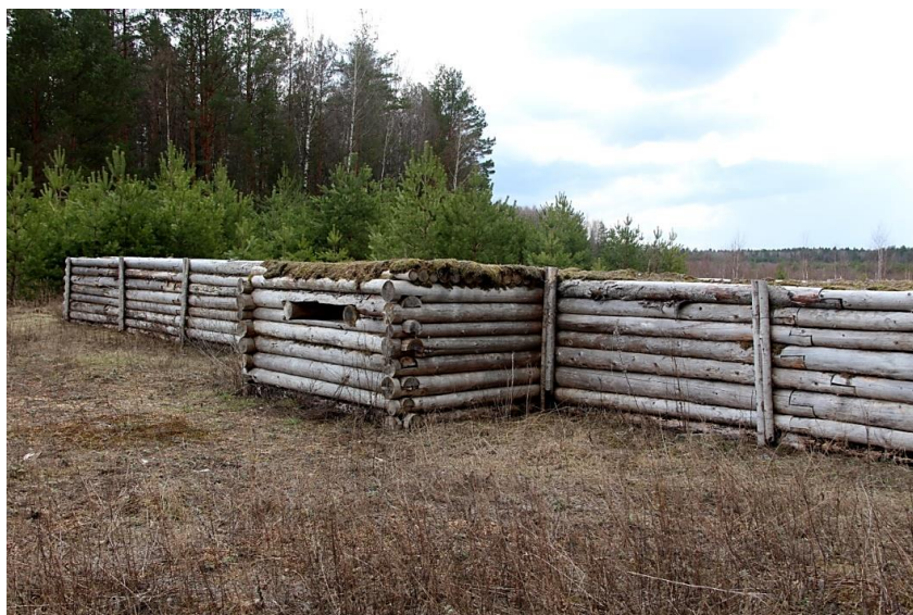
Рис. 9. «Суковский плацдарм»: реконструкция дерево-земляного вала на линии немецкой обороны
