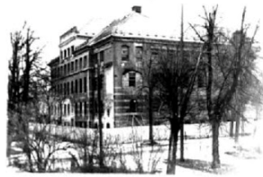
4. Здание, трудно поддающееся реконструкции / облицовано кирпичом /
