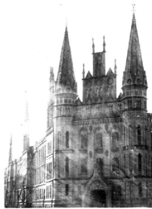
2. Здание, трудно поддающееся реконструкции – решено в ложной готике / в кирпиче /
