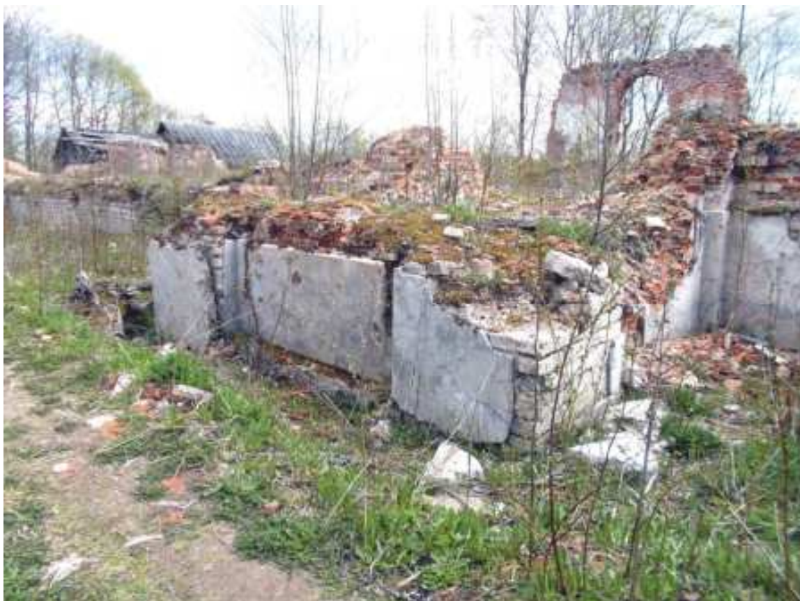
4. Цоколь крыльца северного входа. Фото С. Горбатенко. Май 2020.
