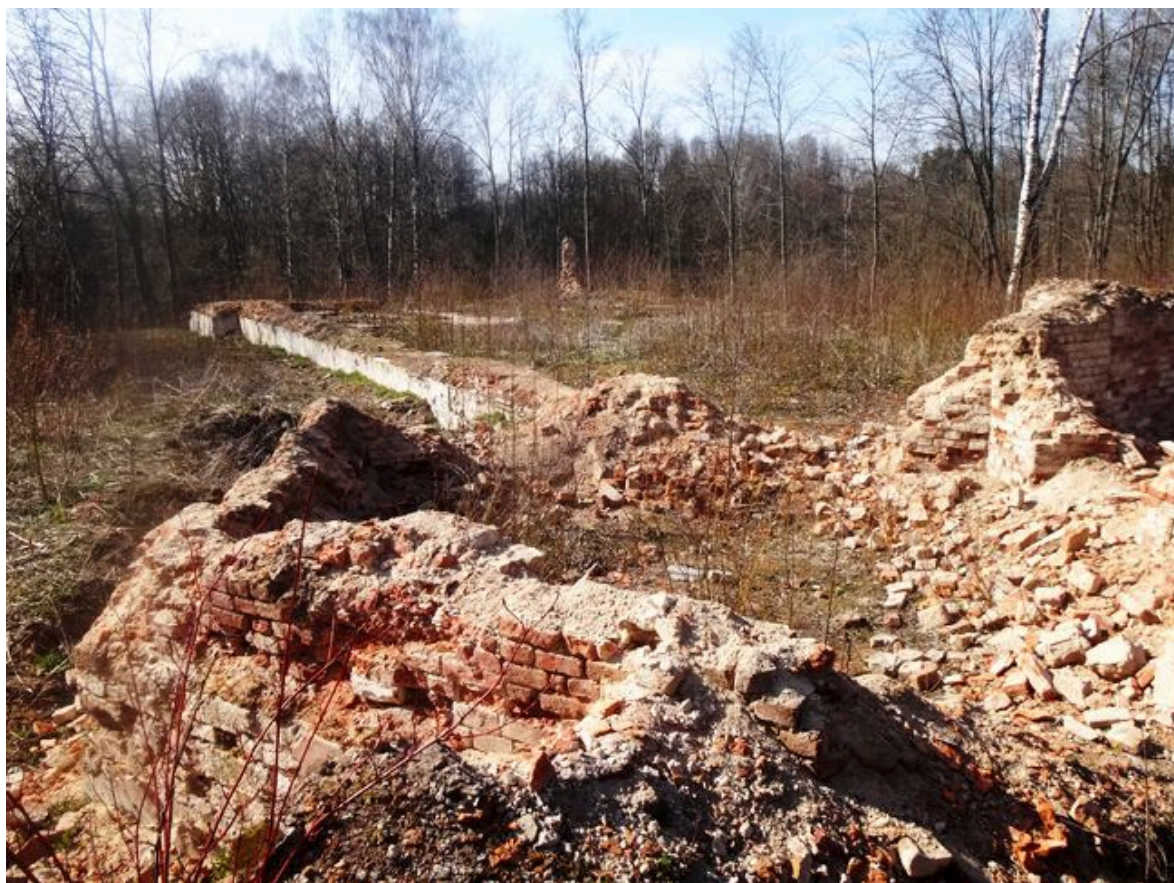
8. Основание южной (центральной) башни, цоколь южной стены. Фото С. Горбатенко. Май 2020.
