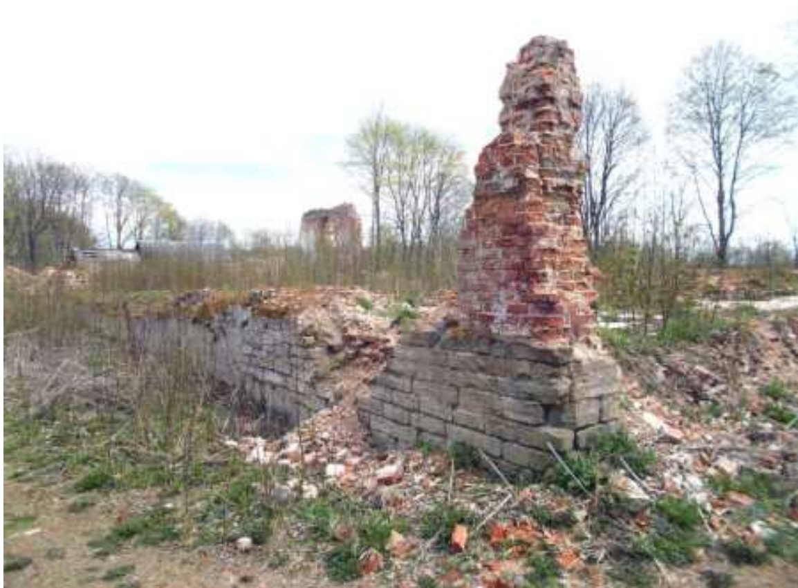
2. Цоколь северной стены и угол северо-западной башни. Фото С. Горбатенко. Май 2020.
