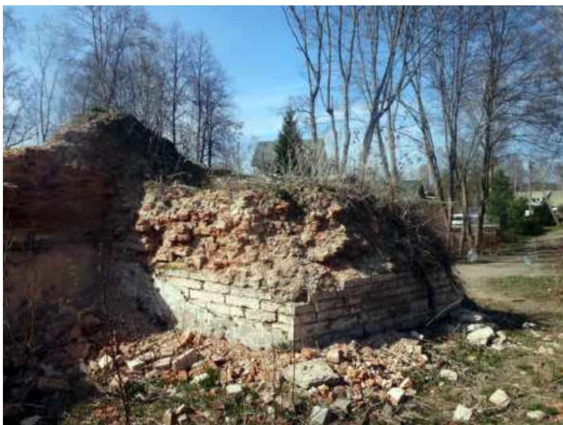
11. Цоколь северо-восточной башни. Фото С. Горбатенко. Май 2020.
