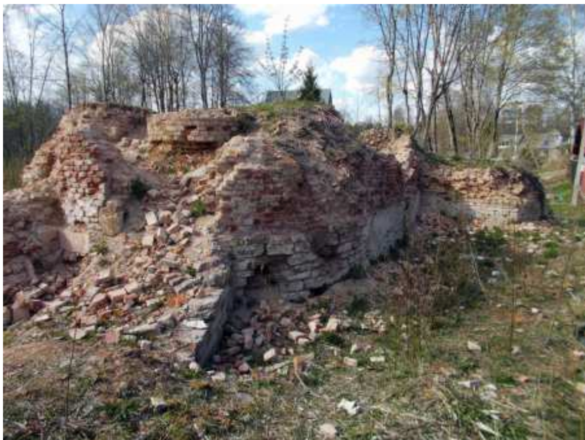
10. Основание главной (восточной) башни. Фото С. Горбатенко. Май 2020.
