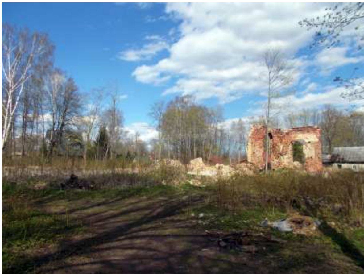
6. Общий вид с юго-запада (с фрагментами южной стены и эркера). Фото С. Горбатенко. Май 2020.
