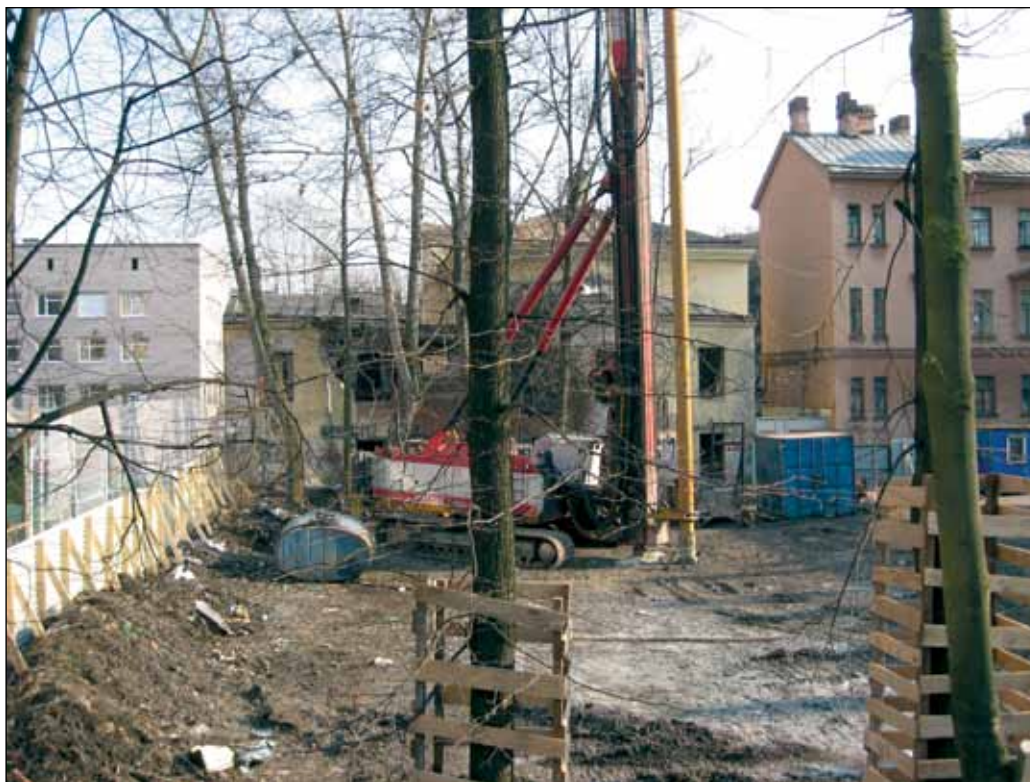
Илл. 58. Вид на участок от дома 63 по 8-й линии В. О.: на заднем плане флигели Благовещенского Синодального подворья, слева забор школы №28. Фото Н.В. Лаврентьева, 10 апреля 2010 г.
